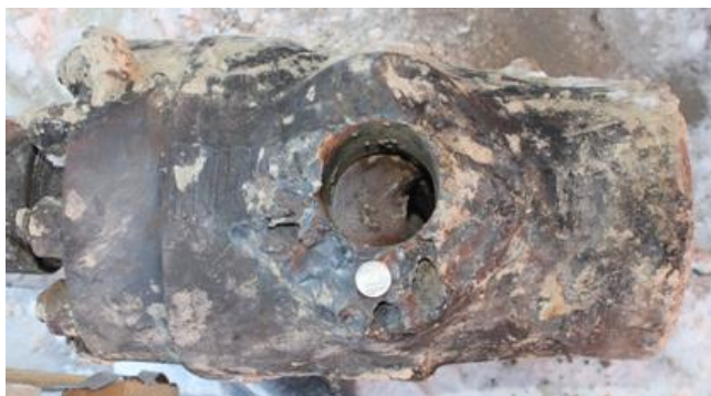
Рис.1. Срезанный лазерным лучом фрагмент газовой арматуры. Северо-Губкинское месторождение. Январь 2015 г. Время резки ~ 20 мин.
