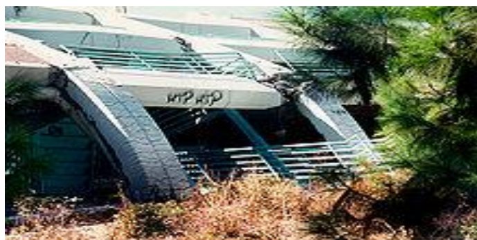
Рис. 2. Гараж в Нортридже после землетрясения 1994 года
