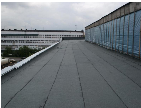
Рис. 5. Покрытие мягкой кровлей промышленного здания
