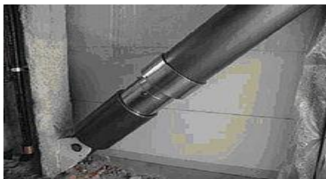
Рис. 9. Гистерезисный, жидкостно-вязкоупругий демпфер в сейсмостойких зданиях
