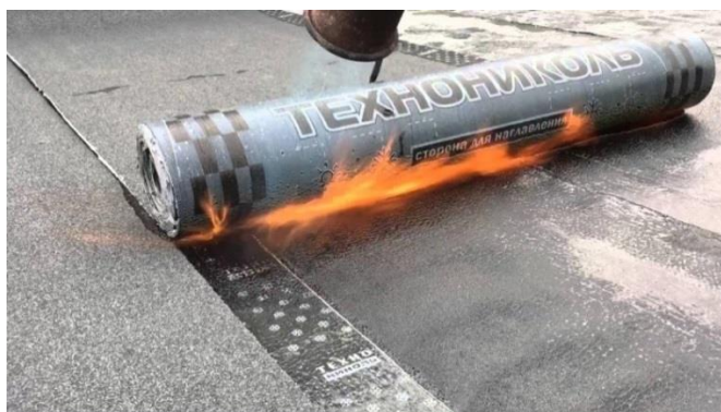
Рис. 6. Покрытие наплавляемой кровлей промышленного здания
