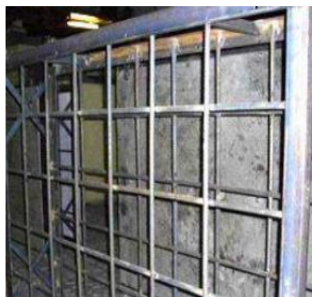
Рис. 3. Армокаркас с продольными рамами жесткости
