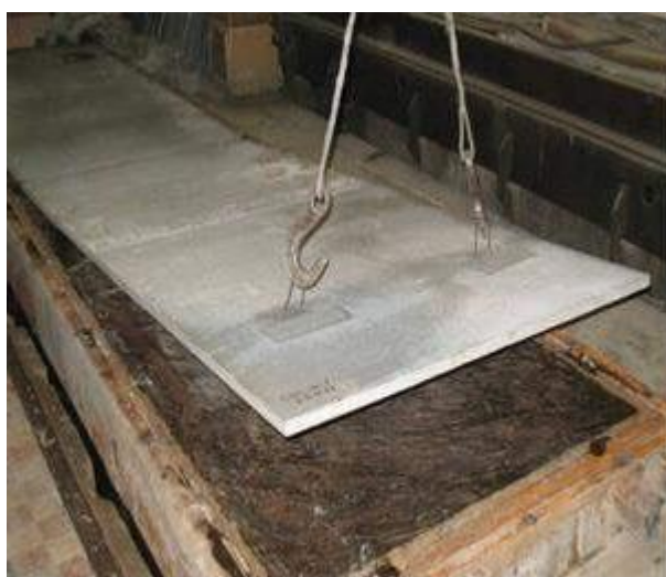
Рис. 1. Распалубка сталефибробетонного листа толщиной 30 мм
