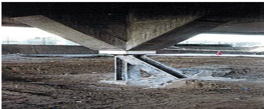
Рис. 12. Конструктивные особенности приподнятого основания здания (ПОЗ)
