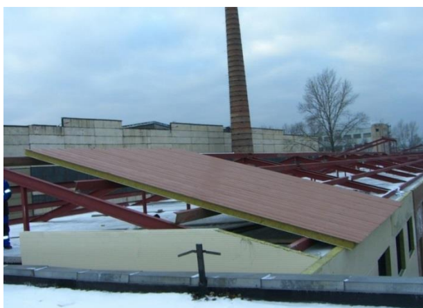
Рис. 2. Покрытие сэндвич-панелями промышленного здания
