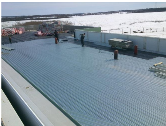
Рис. 3. Покрытие профнастилом промышленного здания
