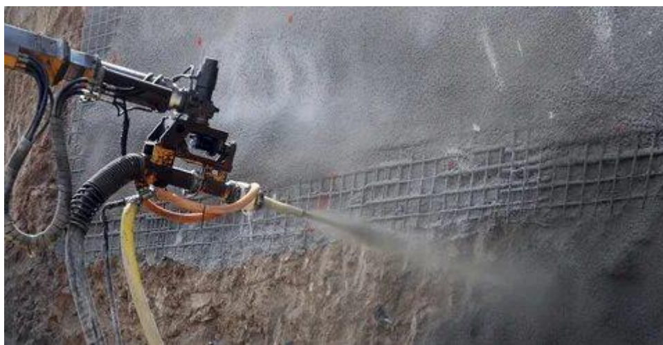
Рис. 1. Торкретирование поверхности
