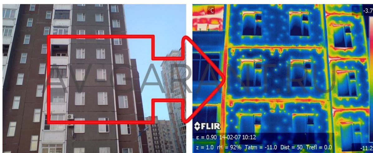
Рис. 2. Мостики холода на тепловизоре
