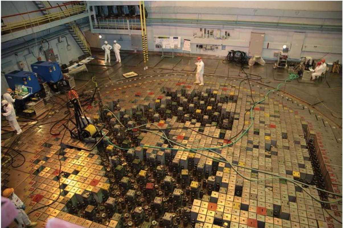
Рис. 2. Демонтаж графитовых кладок
