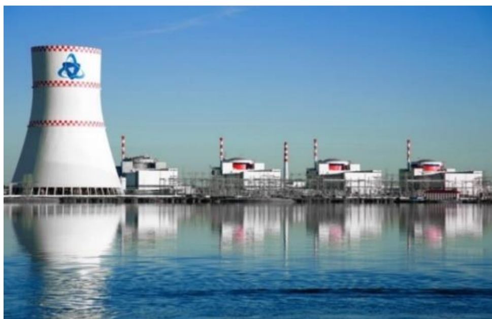
Рис. 1. Общий вид АЭС
