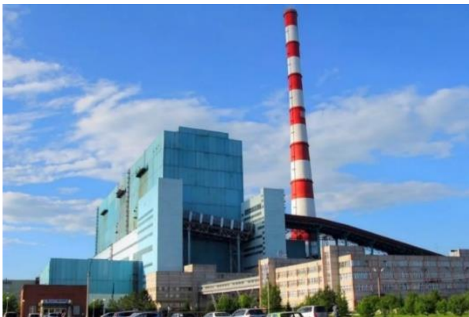
Рис. 1. Общий вид Берёзовской ГРЭС
