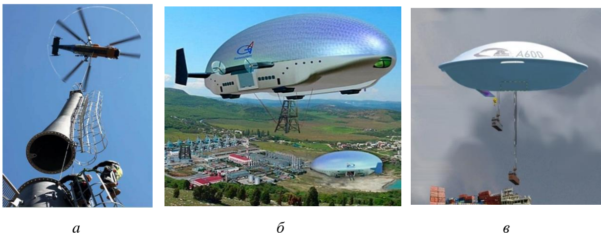
Рис. 3 Монтаж конструкций с помощью: а – вертолѐта Ка-32; б, в – дирижаблей (проекты)
