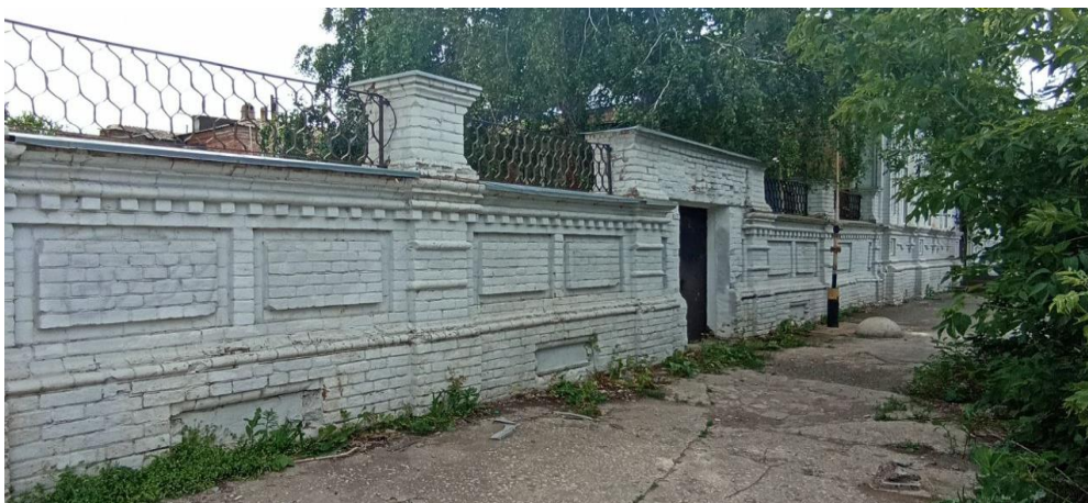
Рис. 3. Кирпичная ограда особняка выполнена из единого материала с домом в архитектурном ансамбле
