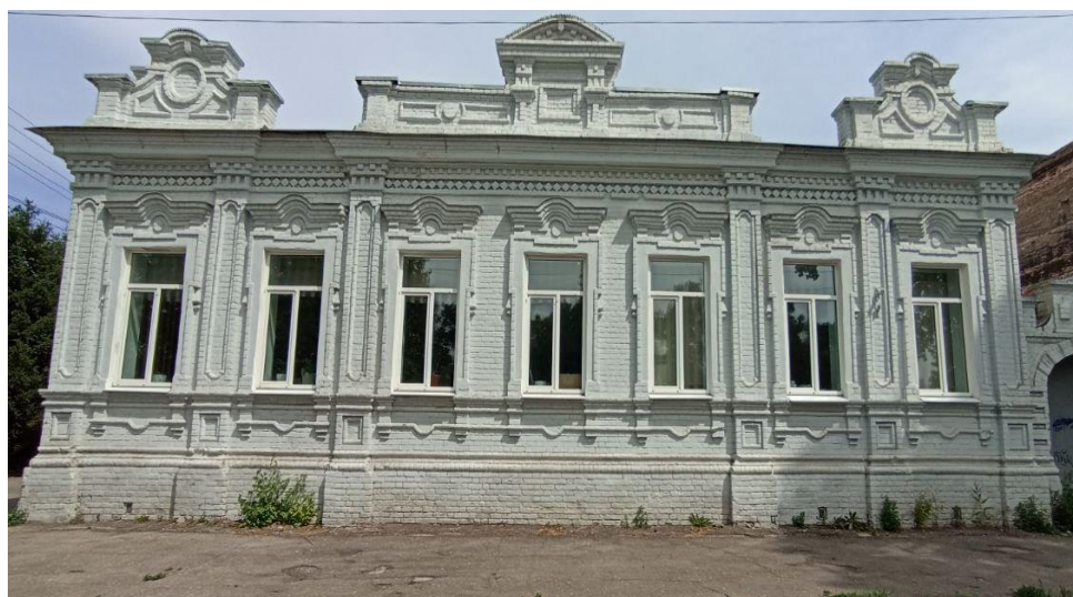
Рис. 2. Фасад особняка купца Лобанова на улице Ленина, 13
