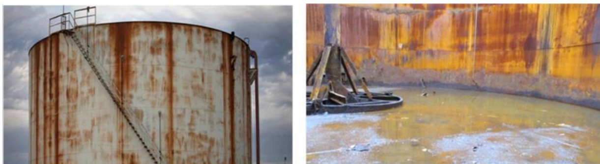
Рис. 1. Коррозия стальных сооружений: а – вертикальный цилиндрический резервуар [4]; б – конструкции судовой арматуры [5]
