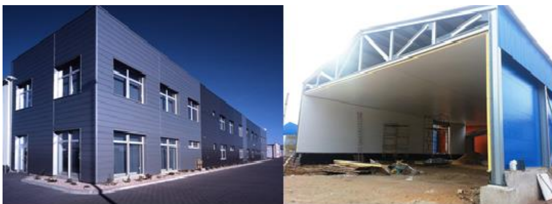
Рисунок 2 – Применение сэндвич-панелей в строительстве жилых домов (слева) и промышленных зданий (справа)
