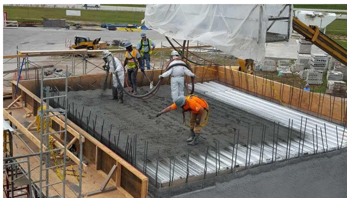
Рисунок 2 – Применение токопроводящего бетона Shot Crete
