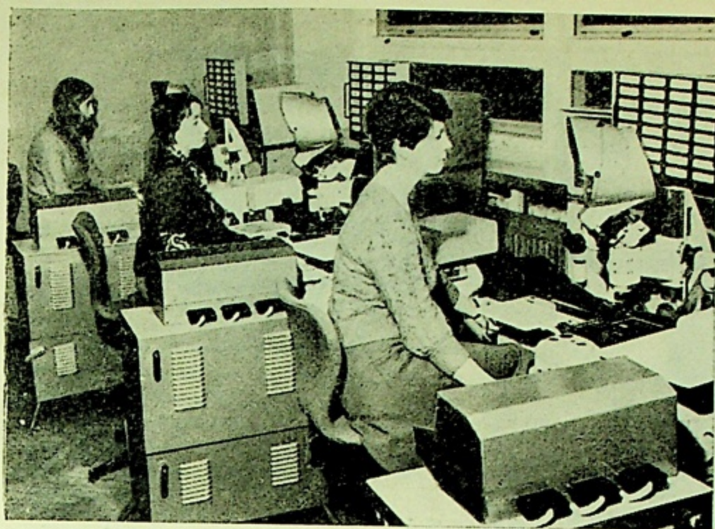
Учебная автоматизированная система для обработки фотографий, полученных на пузырьковых камерах
